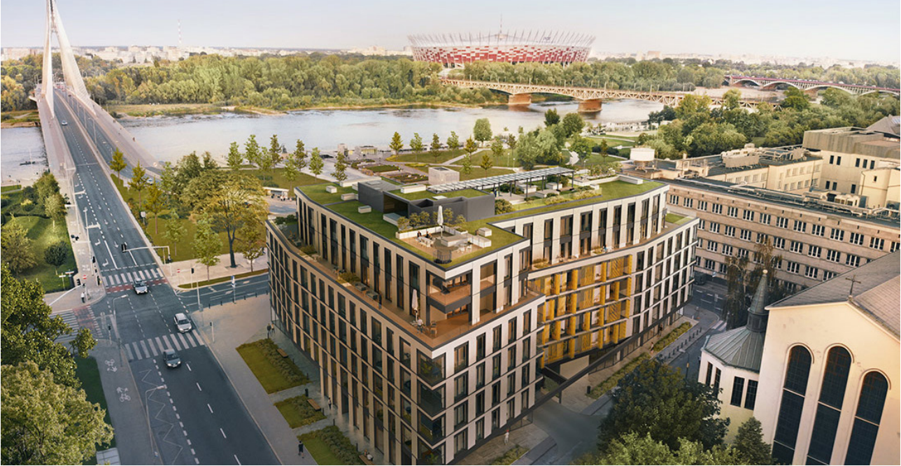
Flisac Apartamenty Powiśle, Warsaw, Poland
